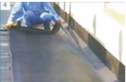
d. Align the membrane Roll
